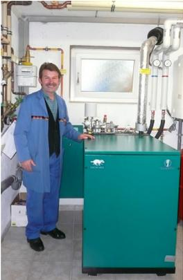
„Seit der Umstellung auf die **Zwei-Zonen-Be-und-Entladung** des Pufferspeichers startet das BHKW **nur noch einmal pro Tag!** Das für die Spitzenlast eingesetzte Gas-Brennwertheizgerät schaltet sich erst ab einer Außentemperatur von etwa  $-10^{\circ}\text{C}$  dazu.“
